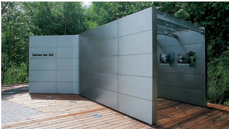
Die Ausstellungspavillons des „Meteorit“-Museums in Essen sind mit zweiseitig gewalzten Blechen bekleidet.
